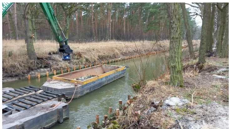
Sedimentationsbecken für die Schlammentwässerung
